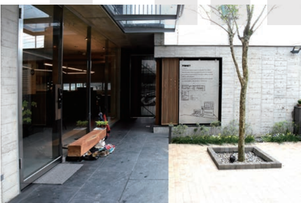
↓ 這是從另一個角度看內院，左邊就是辦公室，特別採用大片的玻璃牆，除了能為室內空間創造良好採光，還能營造整體空間的開闊感。
